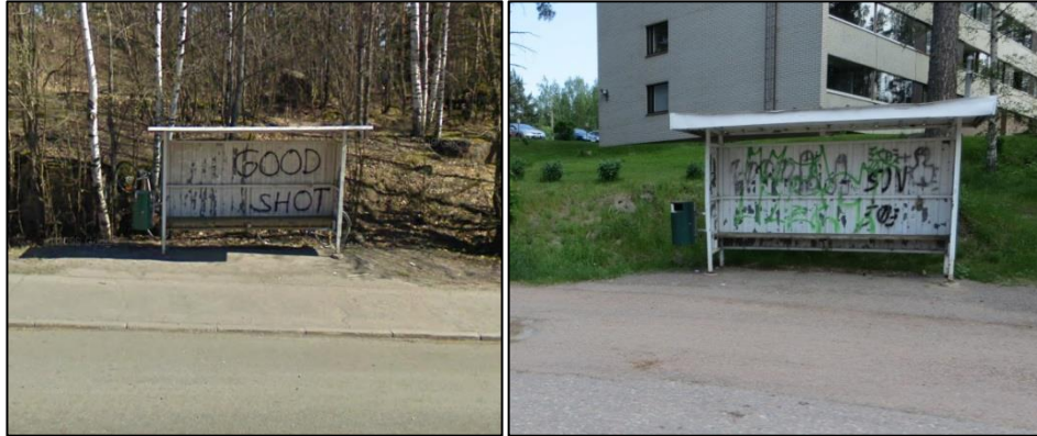
Kuva 12. Huonokuntoiset pysäkkikatokset Valkontieellä ja Valkolammentieellä
