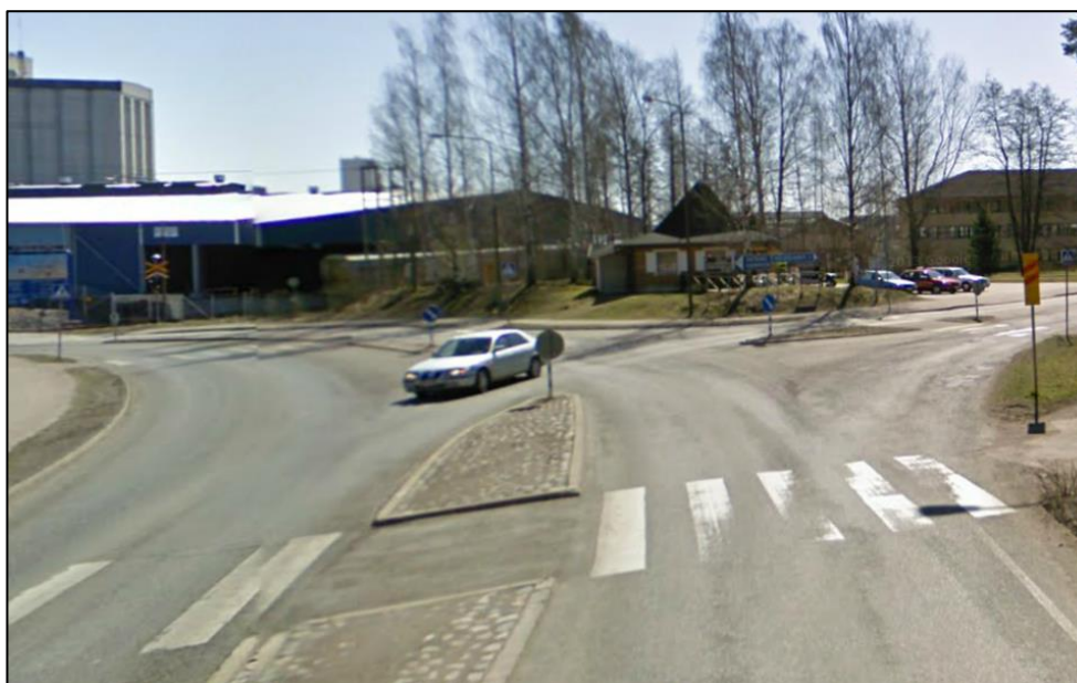
Kuva 6. Valkontien ja Valkolammentien kanavoitu tulppaliittymä
