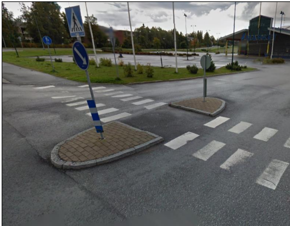
Kuva 16. Keskisaarekkeellinen suojatie Ylöjärvellä
