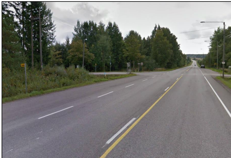
Kuva 13. Antinkyläntien kohdalla sijaitseva joukkoliikenteen pysäkki, jossa ei ole turvallista kevyen liikenteen ylityskohtaa.
